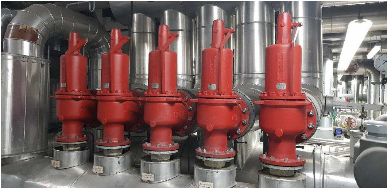
Abbildung 22 Dampfsicherheitsventile 0,5bar
